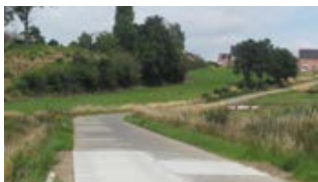
Réfection de dalles Préval à Archennes
