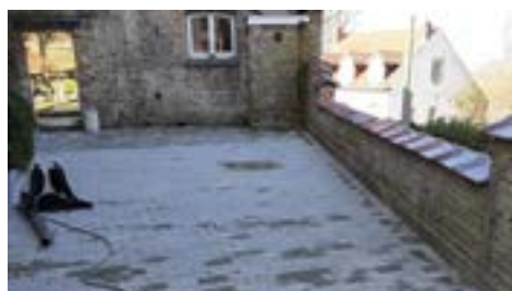
Réfection de la cour intérieure d'un bien communal situé à Biez
