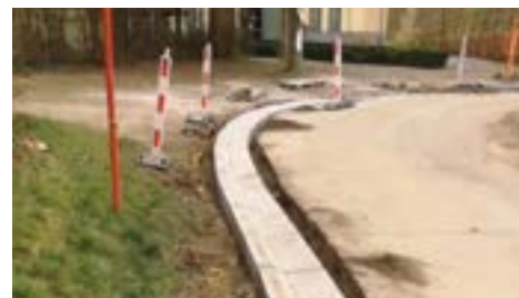
Pose d'un filet d'eau Rue de Beaumont
