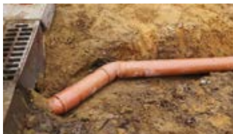
Réparation de l'égouttage Avenue Fernand Labby à Bossut
